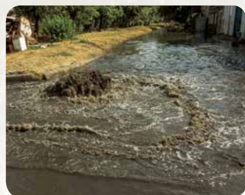
Aguas residuales brotando de una alcantarilla.
